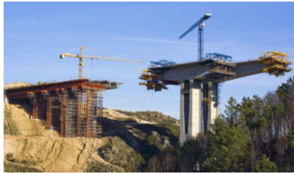
Gradimo ceste, avtoceste, mostove.
